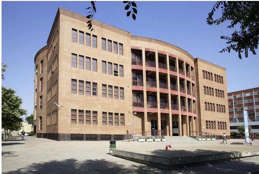
Edificio de docencia (Rojo-Aulas)
