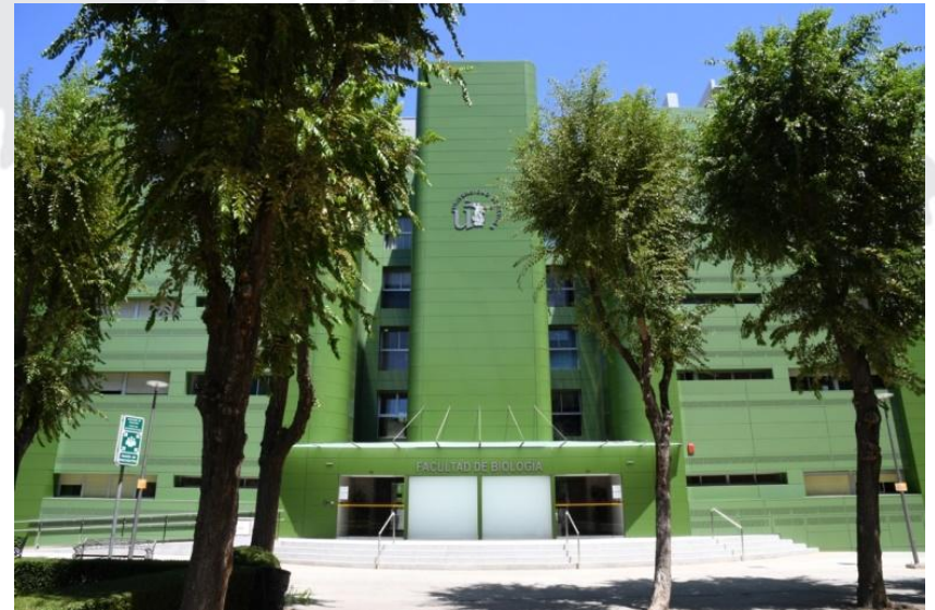
Edificio de Investigación (Verde-Laboratorios)
